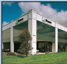
PANDUIT Australia Pty. Ltd. Victoria, Australia cs-aus@panduit.com Phone: 61.3.9794.9020
