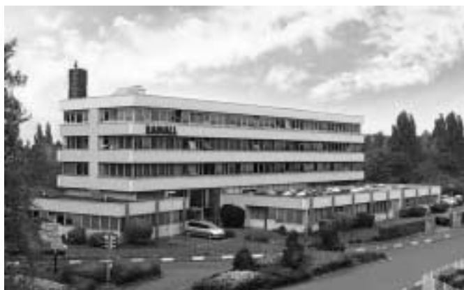
Head Office - Rosny sous Bois
